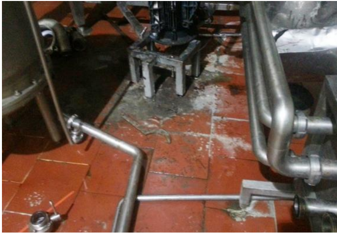
ユークリート施工前の床の状態
