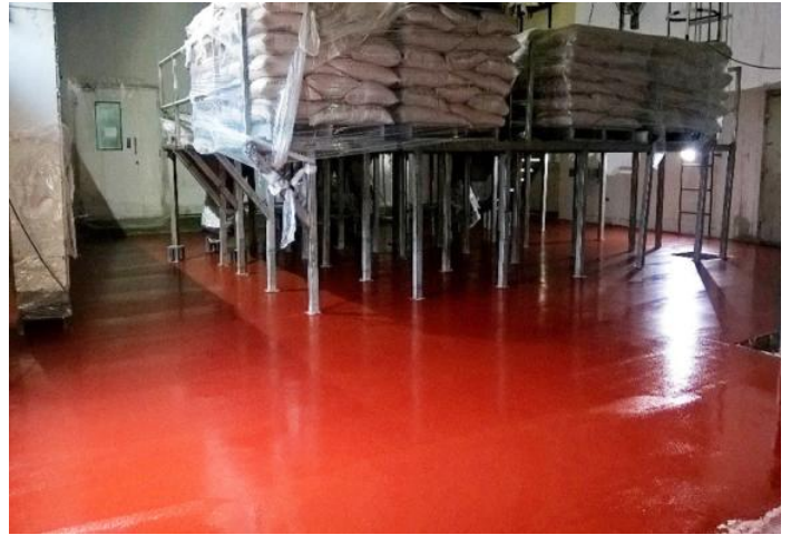
ユークリート® UD200 を施工した砂糖投入エリア
